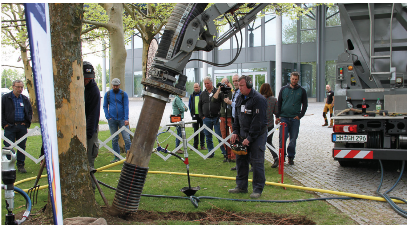
Mit dem Erdsauger der Firma Heitmann werden Wurzeln schonend und zeitsparend freigelegt. | Foto: B_I galabau/S. Bauer
