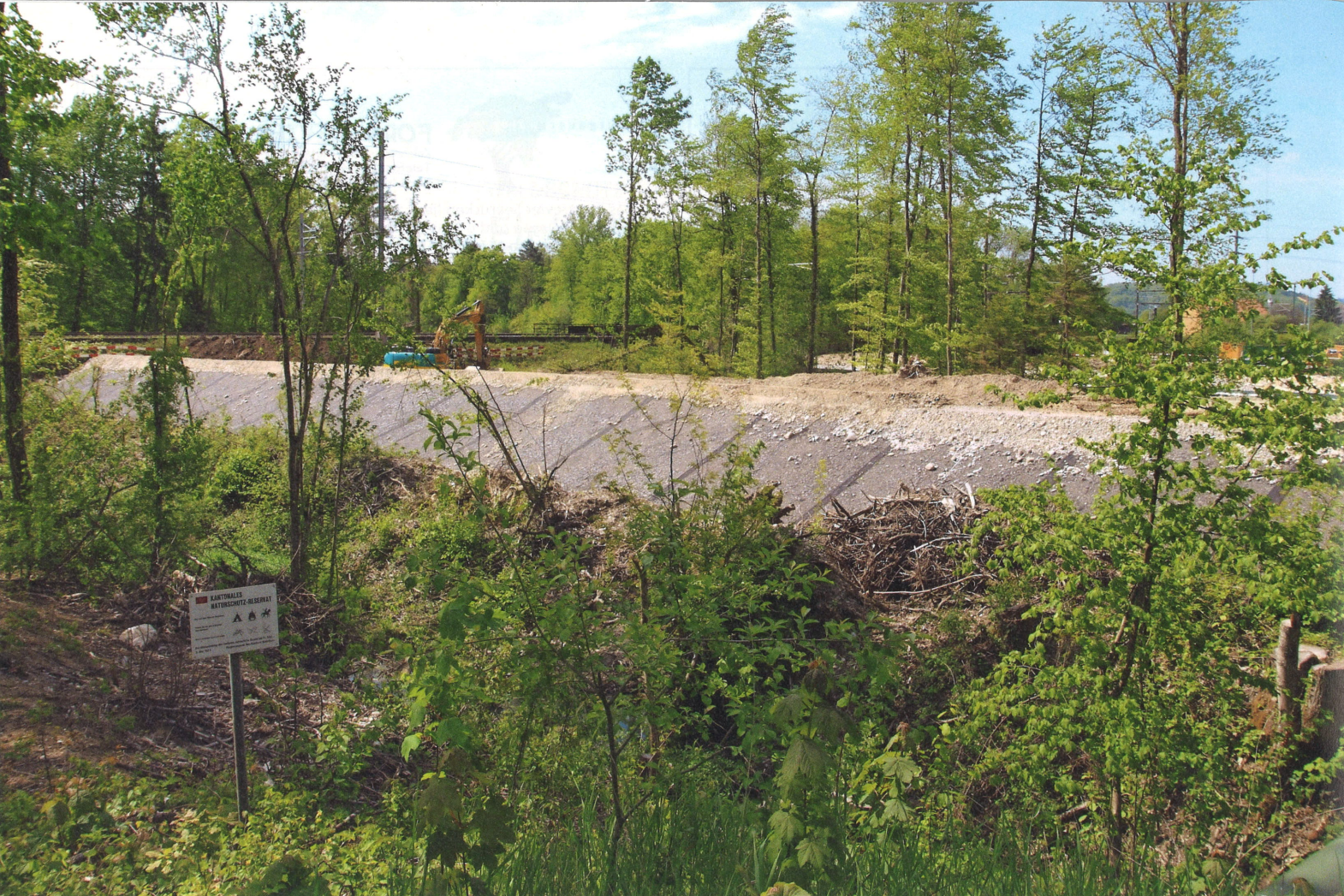
Flussdeich des Hochwasserschutz- und Revitalisierungsprojekts an der Emme zwischen Zuchwil und Derendingen (Kanton Solothurn).
